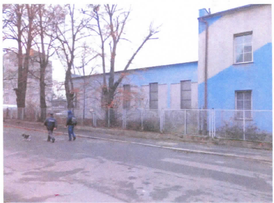
Widok budynku od strony ul. Złotoryjskiej
