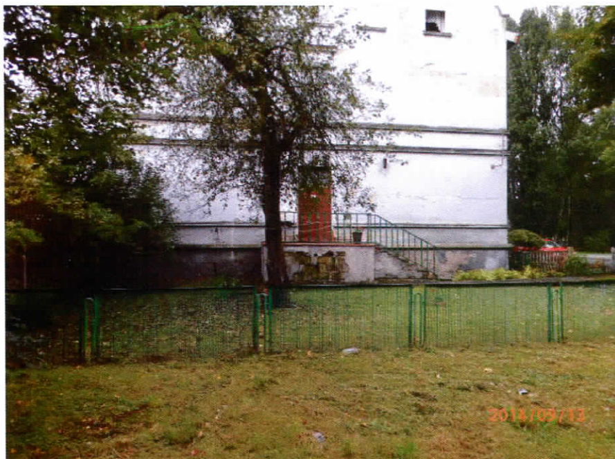
Widok działki nr 75/3 od strony wschodniej. Na pierwszym planie ogrodzenie do przestawienia.
